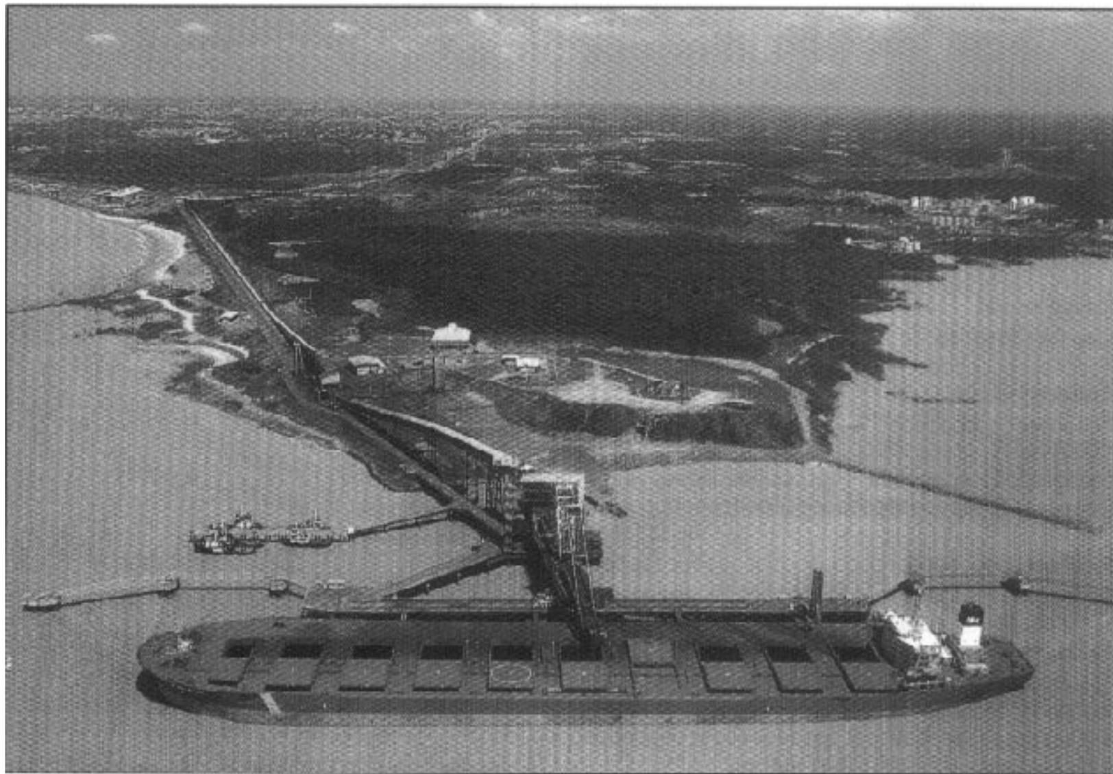
A foto mostra o padrão de um navio graneleiro. Os navios exigem portos com profundidade entre 15 e 20 metros para comportar o calado. Há supergraneleiros com capacidade de transporte de 150.000 a 420.000 toneladas de minério de ferro.
